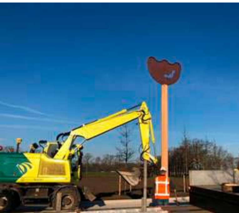
Aanbrengen vleermuispaal in de rotonde Erpseweg
