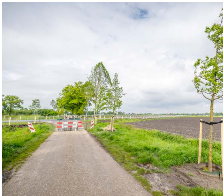
aanbrengen hop-over bij 't Leurke
