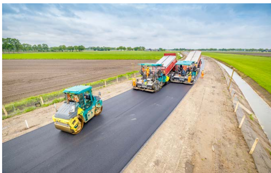
Aanbrengen asfalt op de nieuwe randweg.
